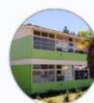
Escuela Pedro de Valdivia $3.986.000 Mantenimiento
