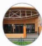
Escuela Andrés Bello $571.753 Mantenimiento
