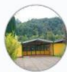
Escuela Especial Nielol $11.701.050 Mantenimiento
