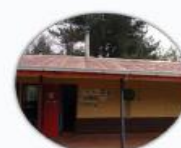
Escuela Lircay $320.000 Mantenimiento
