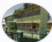
Escuela Trencito $9.994.000 Mantenimiento
