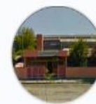
Escuela Manuel Recabarren $5.249.720 Mantenimiento
