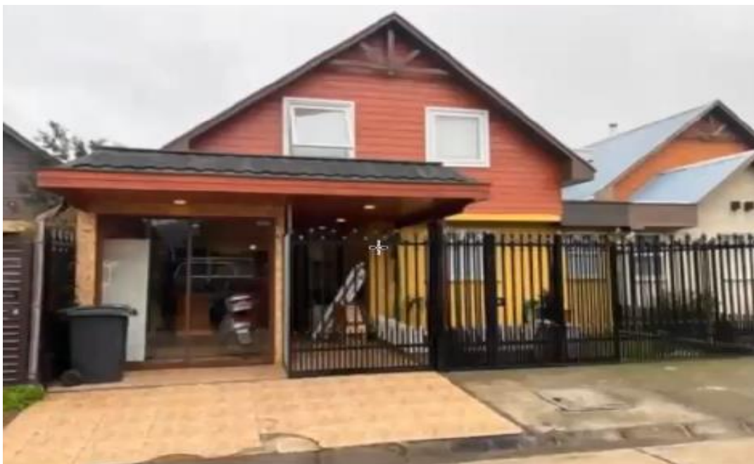
FOTOS DE LA VISITA INPECTIVA DE LA UNIDAD DE INSPECCION
