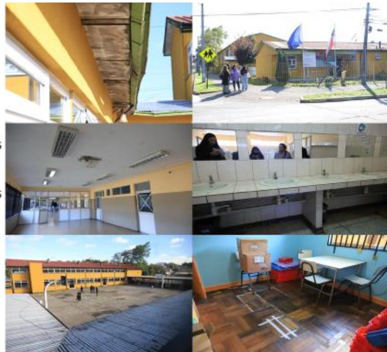
La **Escuela Los Avellanos** tuvo cambio de ventanas termo panel y EIFS, con el saldo se espera reponer toda la cubierta dañada por filtraciones; y con este proyecto se solucionaría el recambio de cubierta, las bajadas de aguas lluvias, reposición de pavimento, luminarias. Por temas de seguridad los cierres perimetrales serán una intervención grande.
