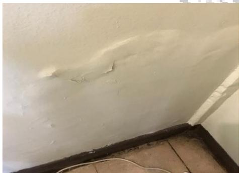
Muros deteriorados por humedad
