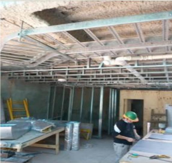
Estas otras imágenes, señala que, son del primer piso de locales exteriores, específicamente trata por calle Rodríguez, en donde se está instalando el producto que retarde el fuego de la estructura metálica y a mano derecha el equipo de instalaciones de clima colocándolo en los cielos.
