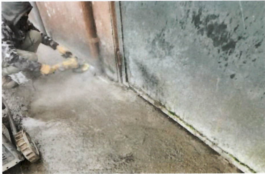
Imagen – Desbaste pavimento
