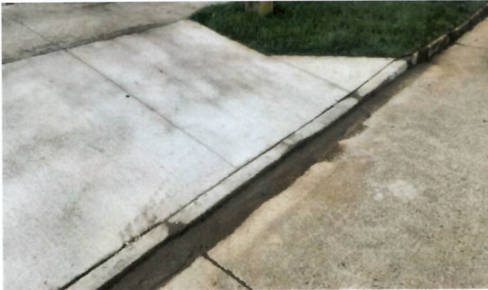
Imagen – Emboquillado soleras
