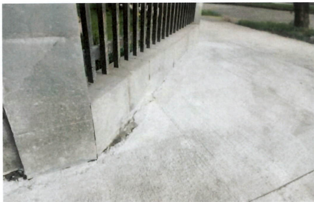
Imagen - Emboquillado de soleras y reparación pavimentos
