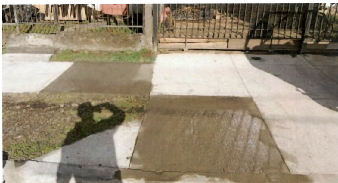
Imagen - Reparación pavimentos
