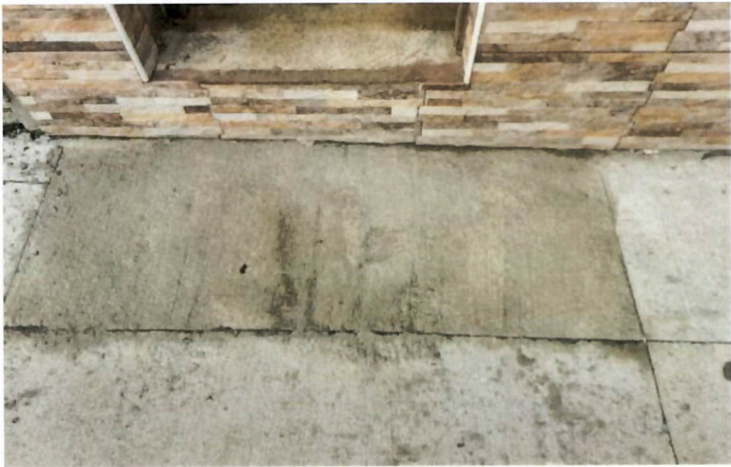
Imagen – Desbaste pavimento
