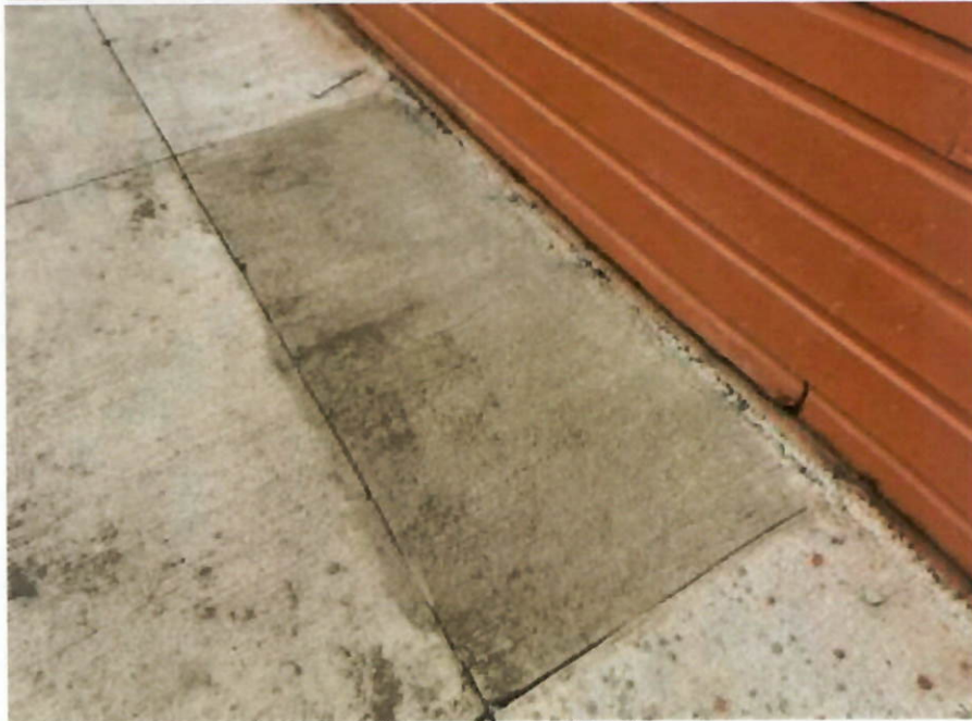
Imagen – Reparación pavimento
