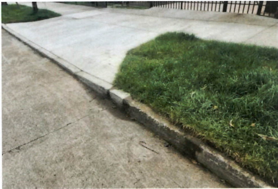
Imagen – Emboquillado soleras
