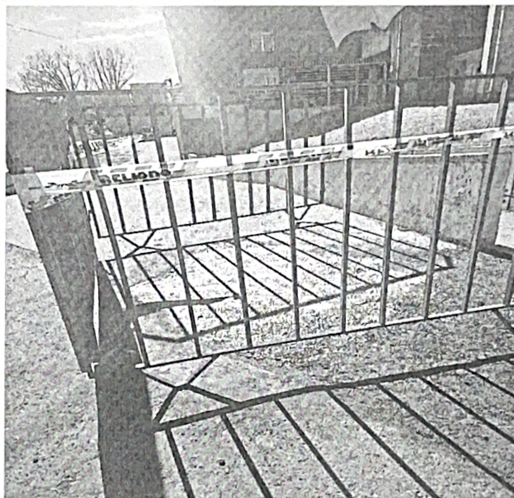
Fotografía N.º 2 – Aislamiento del sector intervenido
