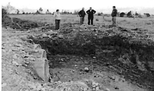
Figura 2.- Atraveso para aguas Lluvias
