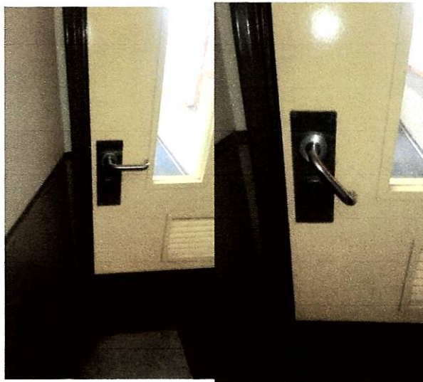
Se arreglaron 2 cerraduras de puertas.
