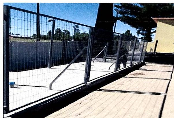
3.- Se requiere dar terminación a losa, se deberá hormigonar en el ancho de la losa.
